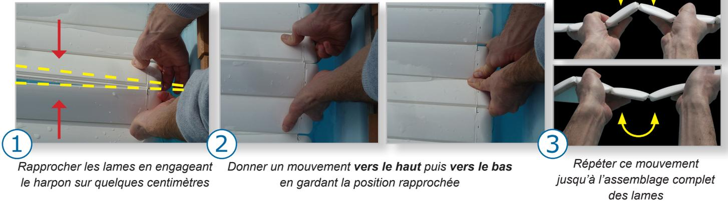
① Rapprocher les lames en engageant le harpon sur quelques centimètres
